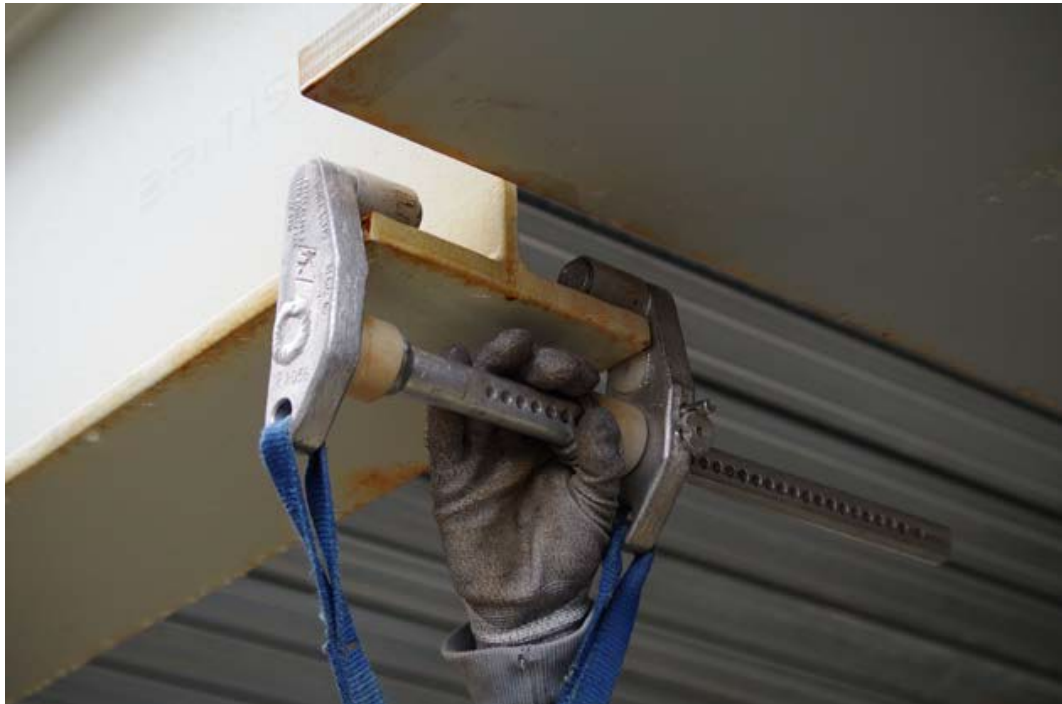
Foto 2: Primer accidente: planeador de viga en el extremo abierto de la viga (separación de 37 mm de ancho) [Reconstrucción]
